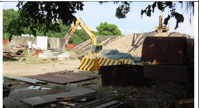
工作照-計畫路線施工處
