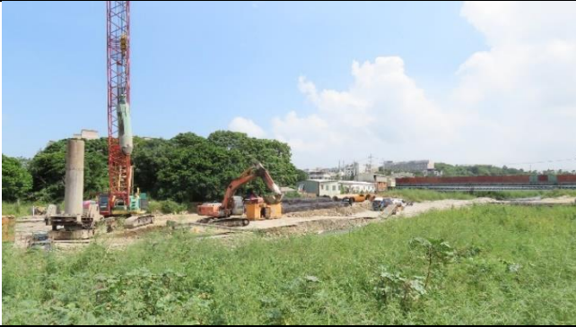
環境照-美村橋下游施工處
