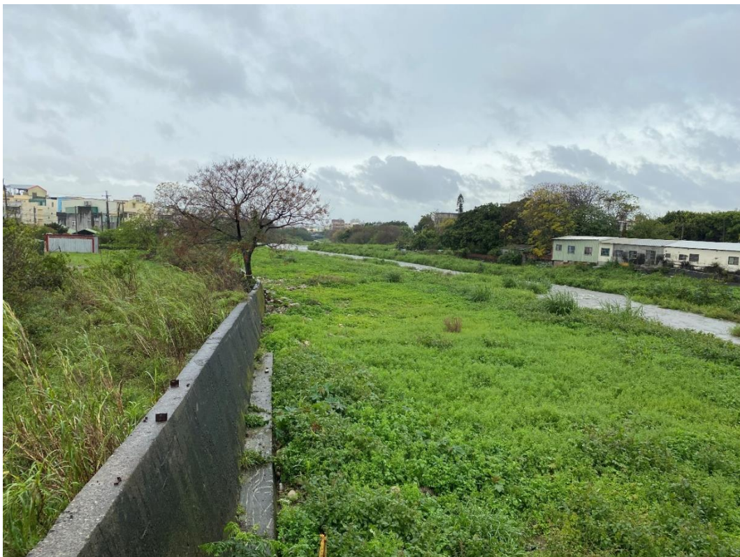
圖 5 橋樑段工區 1 工區環境現況照片
