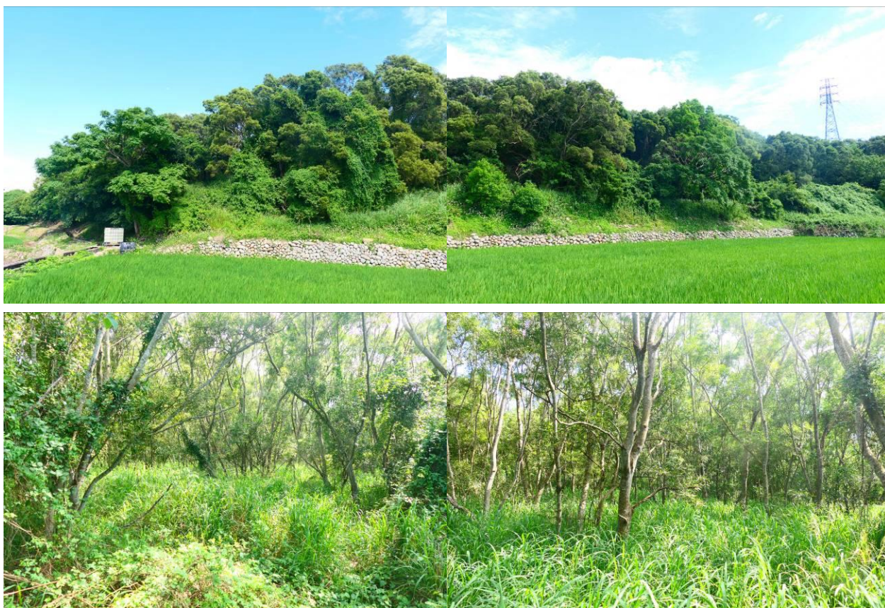
圖 4 大榕樹後山坡地現況照片
