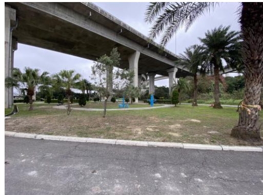
(d)大東公園環境現況
