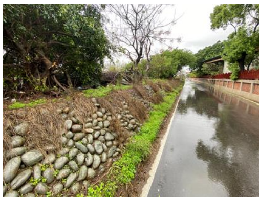
(a)既有道路現況
