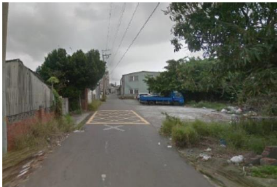
(a)既有道路現況
