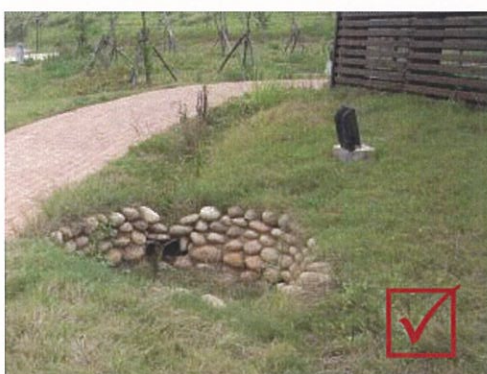
自然草溝與集水井
