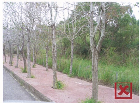
植穴設計樹根欠缺生長空間，影響根系發育，易造成盤根或根部隆起
