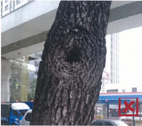
修剪錯誤，造成樹幹腐朽
