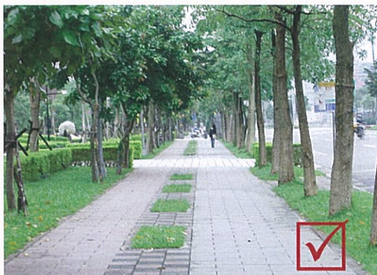
植栽帶設計提供樹根足夠生長空間，有助於根系發育，避免頭重腳輕
