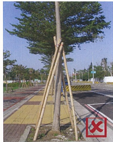
支柱位置過高、支柱過多
