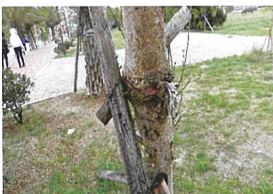
支柱鬆散，固定索纏勒。
