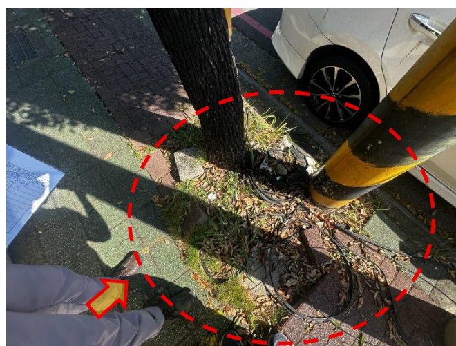
NO3 樟樹-樹根隆起(移除)
