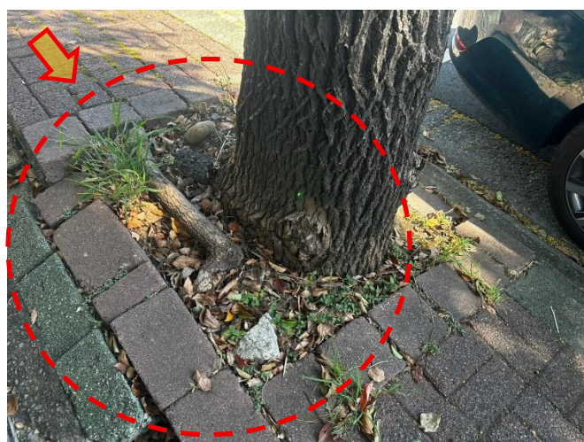
NO4 樟樹-樹根隆起(移除)
