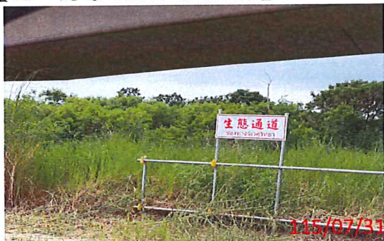
【施工便道之生物通道照片】
