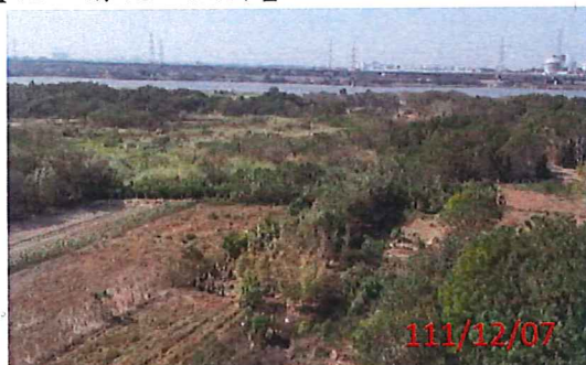
【施工前現地照片】
