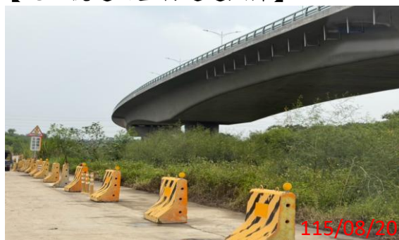
【施工便道之生物通道照片】
