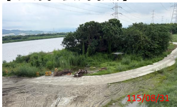
【施工便道之生物通道照片】
