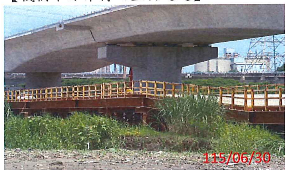
【棧橋下方維持之生物通道】
