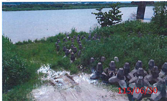
【施工便道之生物通道照片】
