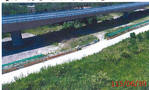
【施工便道之生物通道照片】
