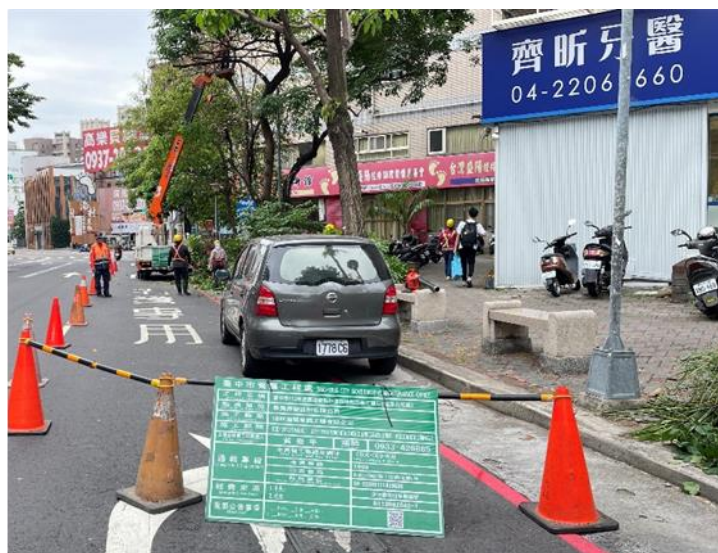
圖、施工廠商景觀樹木種植與移植合格證書與監看
