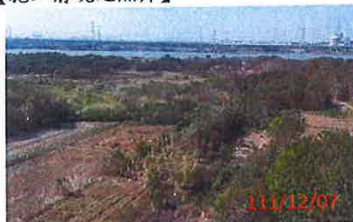
【施工前現地照片】
