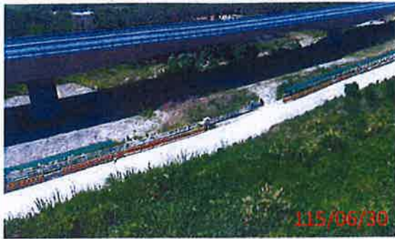
【施工便道之生物通道照片】
