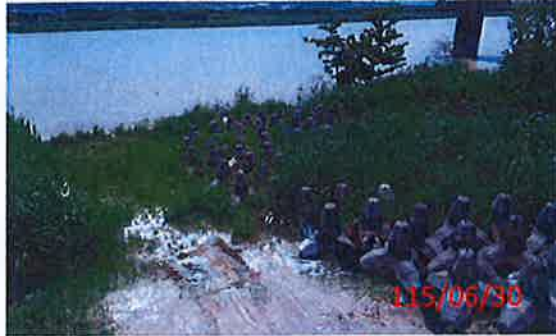
【施工便道之生物通道照片】
