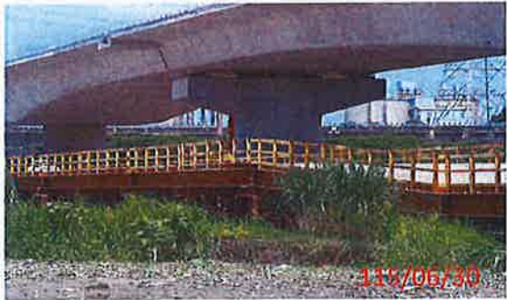
【棧橋下方維持之生物通道】
