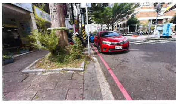
因浮根嚴重破壞鋪面，每年均有鋪面隆起破壞，鋪面、緣石需重複派工改善
