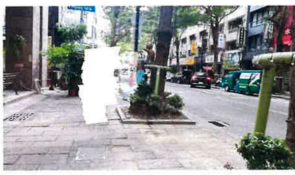
因浮根嚴重破壞鋪面，每年均有鋪面隆起破壞，鋪面、緣石需重複派工改善
