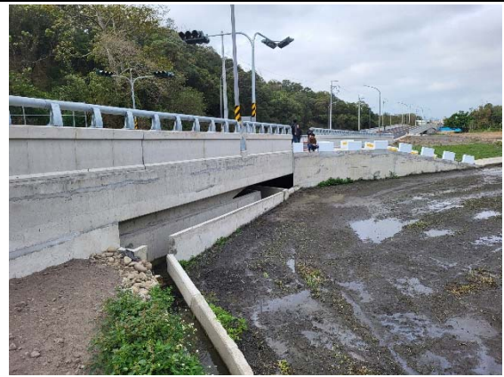
道路排水與灌溉溝渠採分離設計
