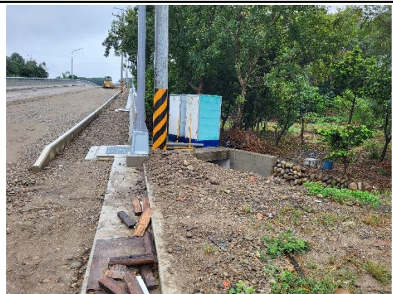
道路排水與灌溉溝渠採分離設計
