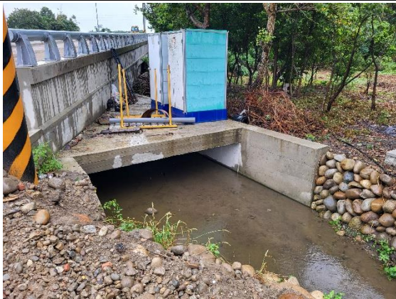
第 1 處(1+260.71)灌溉溝渠排水箱涵
