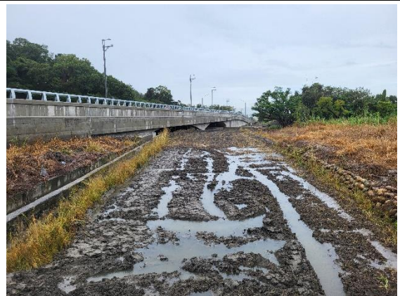
版橋 A-跨橋懸空跨越渠道已完成
