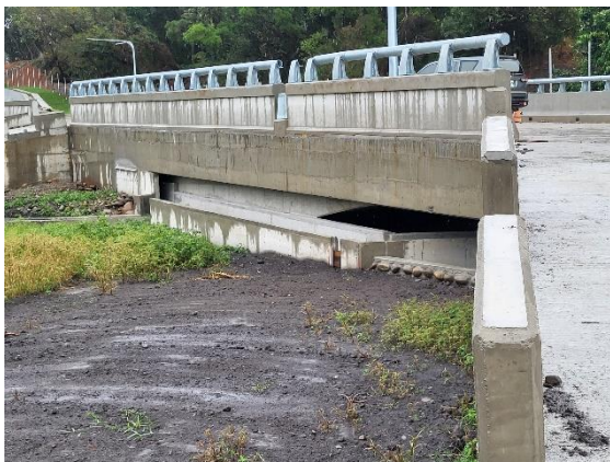
板橋 B-跨橋懸空跨越渠道已完成
