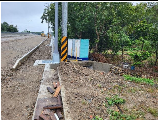
道路排水與灌溉溝渠採分離設計
