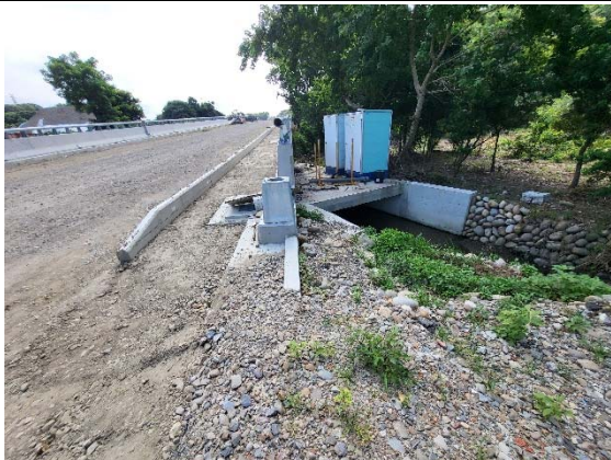
道路排水與灌溉溝渠採分離設計
