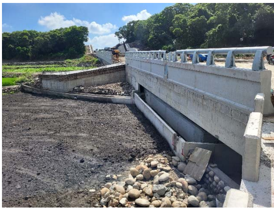
板橋 B-跨橋懸空跨越渠道已完成
