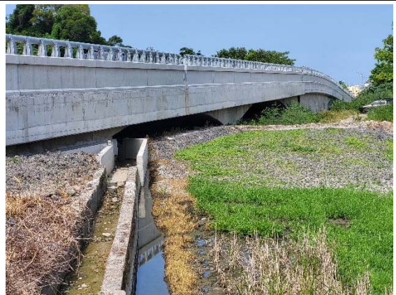
版橋 A-跨橋懸空跨越渠道已完成
