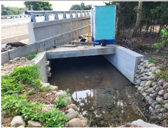
第 1 處(1+260.71)灌溉溝渠排水箱涵
