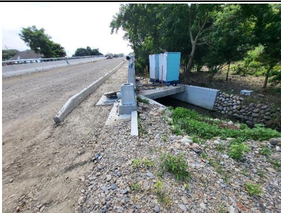
道路排水與灌溉溝渠採分離設計
