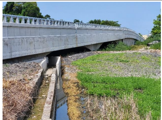
版橋 A 已完成
