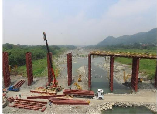
說明：下游處已分段進行便橋之搭設，除必要施工所需腹地外，已盡量縮減水域棲地之干擾，且維持常流水狀態。
