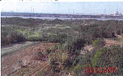
【施工前現地照片】
