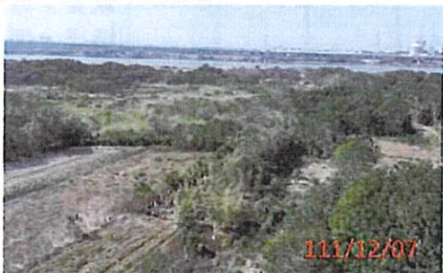
【施工前現地照片】
