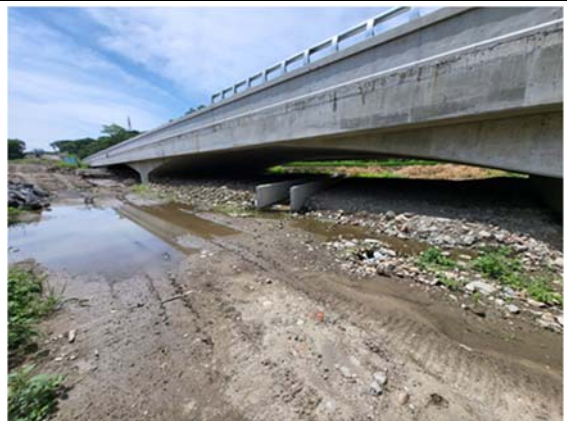
版橋 A 已完成
