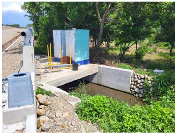
第 1 處(1+260.71)灌溉溝渠排水箱涵
