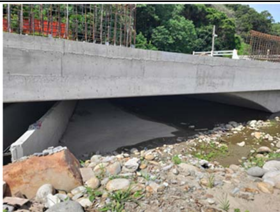
板橋 B 施工中
