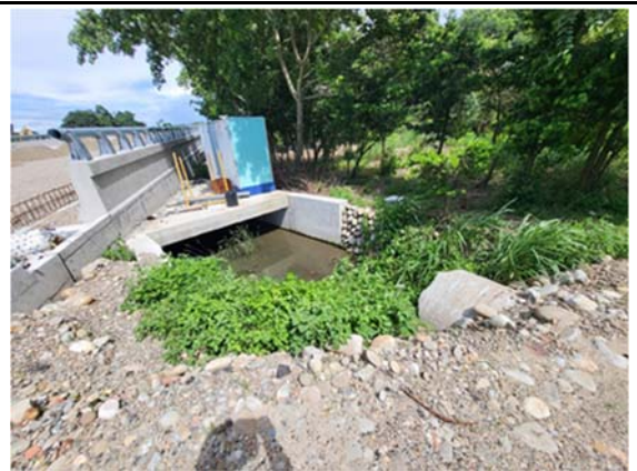
1+260.71 排水箱涵建置完成
