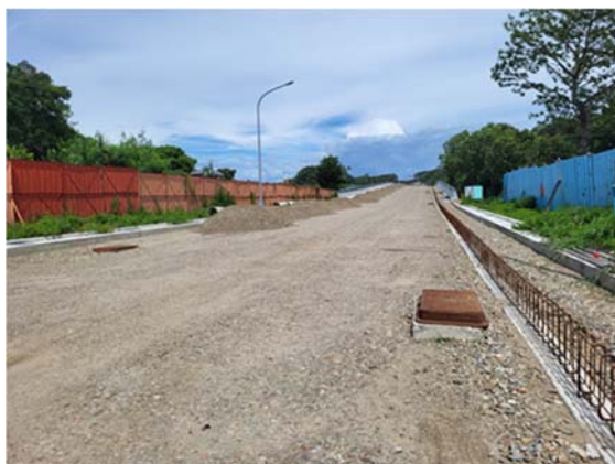
灌溉排水箱涵施工中，設置臨時性引水管線避免水路斷流。
