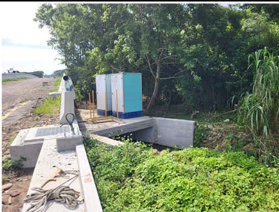
第 1 處(1+260.71)灌溉溝渠排水箱涵
