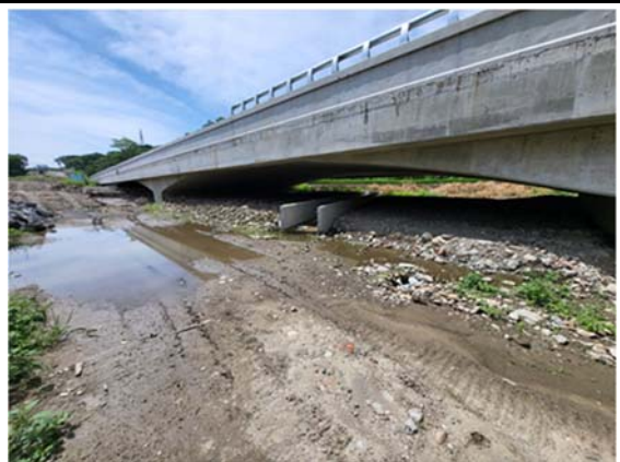
版橋 A 已完成
