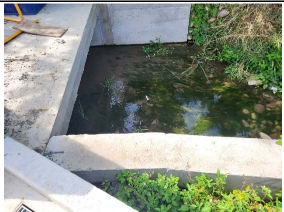
1+260.71 排水箱涵建置完成
