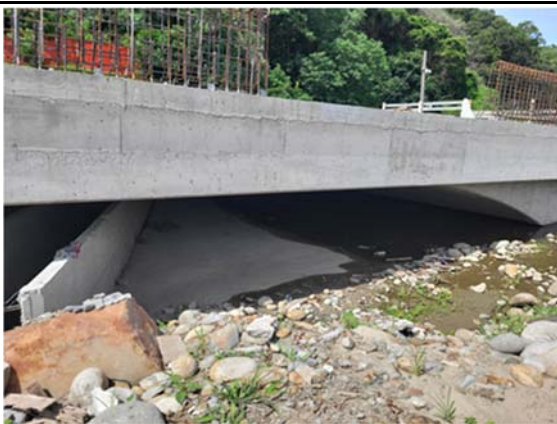
板橋 B 施工中
