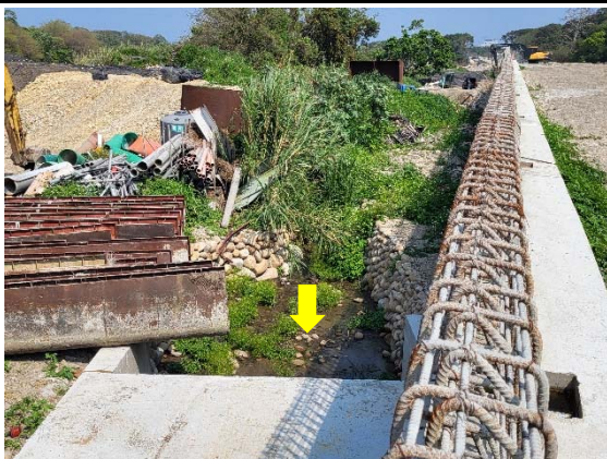
1+260.71 排水箱涵建置完成，臨時性涵管已拆除
