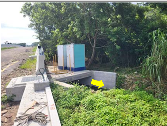
道路排水與灌溉溝渠採分離設計
