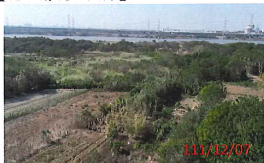
【施工前現地照片】
